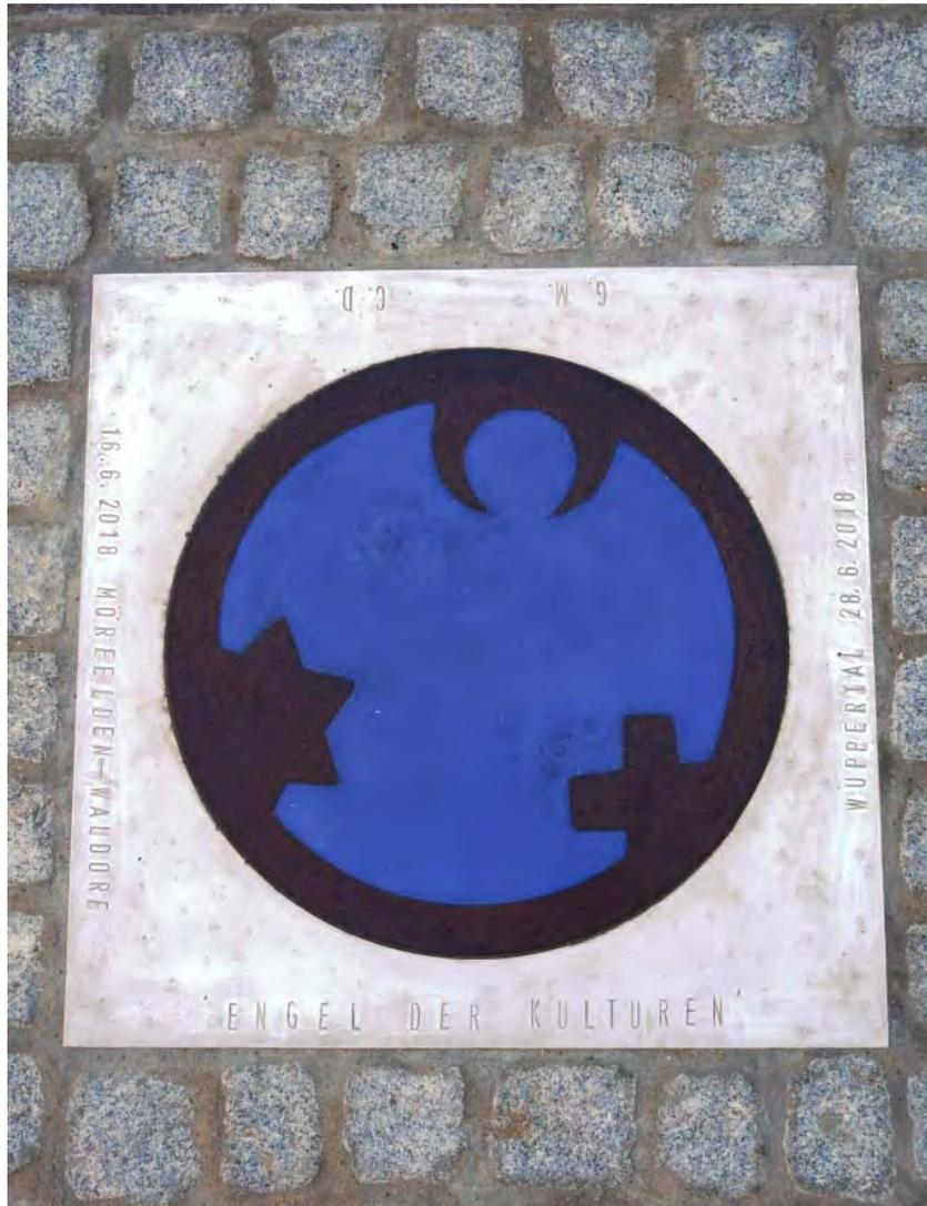
Der **Engel der Kulturen** wird als Bodenintarsie - bestehend aus dem Ring (Stahl), blau eingefärbtem Spezialbeton und einem beschrifteten Rahmen aus Aluminium - in den Boden eingelassen.
